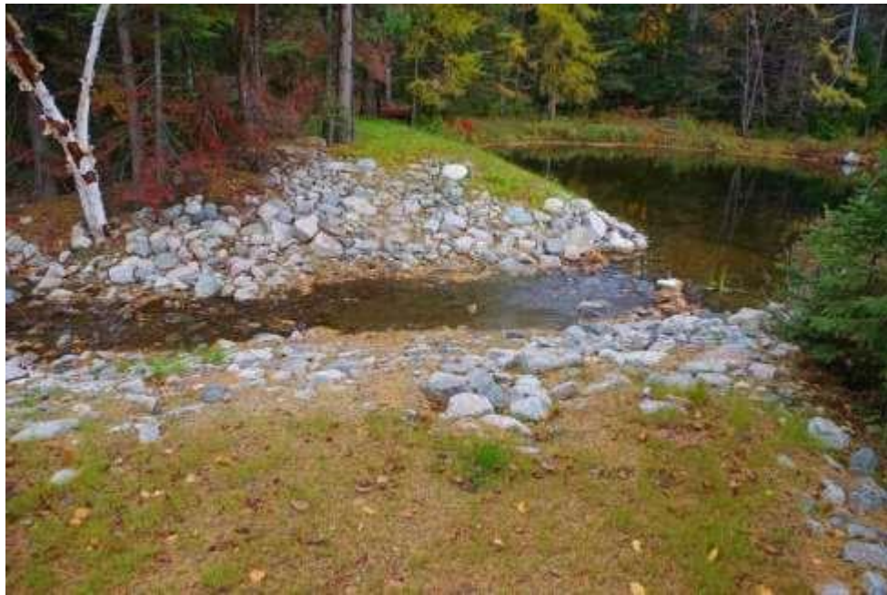
Photo 6 Exemple d'un exutoire en enrochement. Lac Roger, Wentworth.
