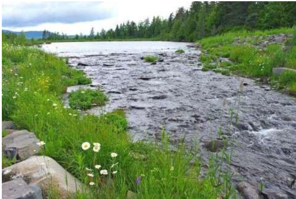
Photo 7 Exemple d'un exutoire en enrochement. Lac Drolet.
