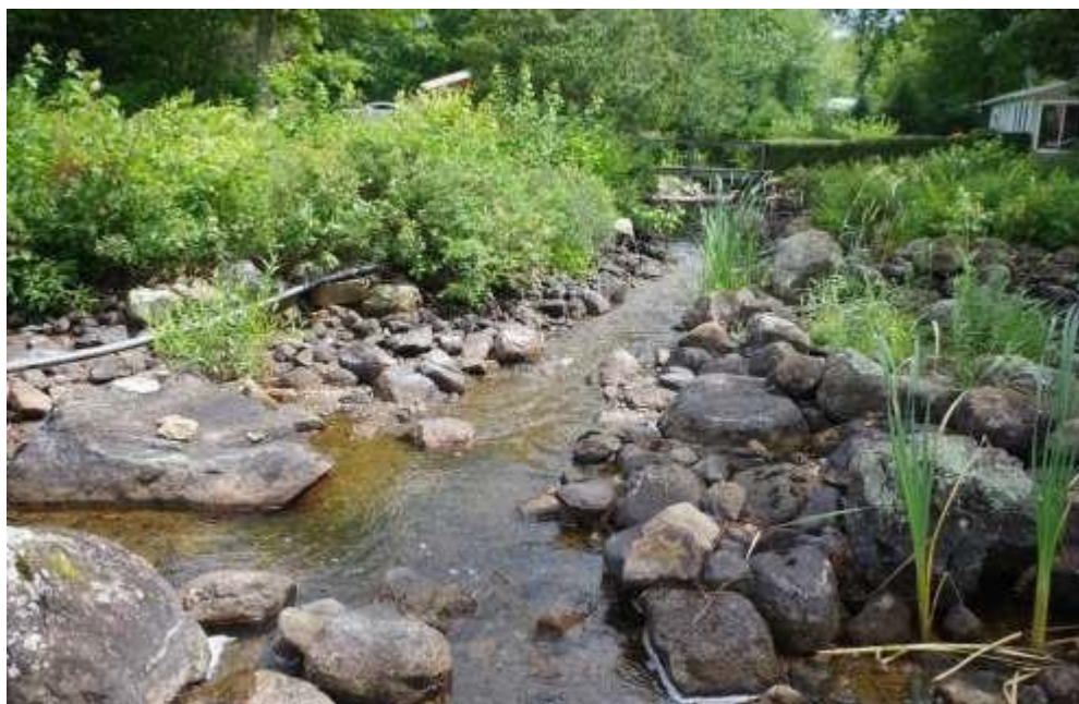
Photo 4 Dans la partie aval de l'exutoire, il semble que l'écoulement ait été canalisé par des interventions anthropiques. Durant les périodes d'étiage, ces interventions contribuent à l'abaissement du niveau d'eau du lac Louisa.
